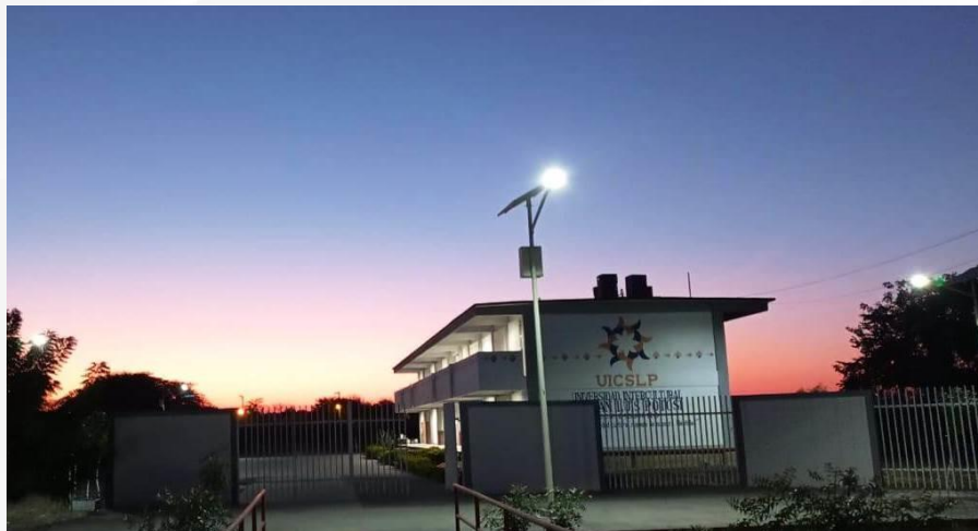
Fig. Instalaciones Tanquian de Escobedo.
