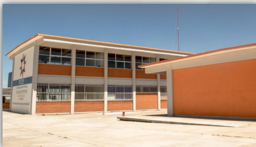
Fig. Instalaciones Villa de Reyes.
